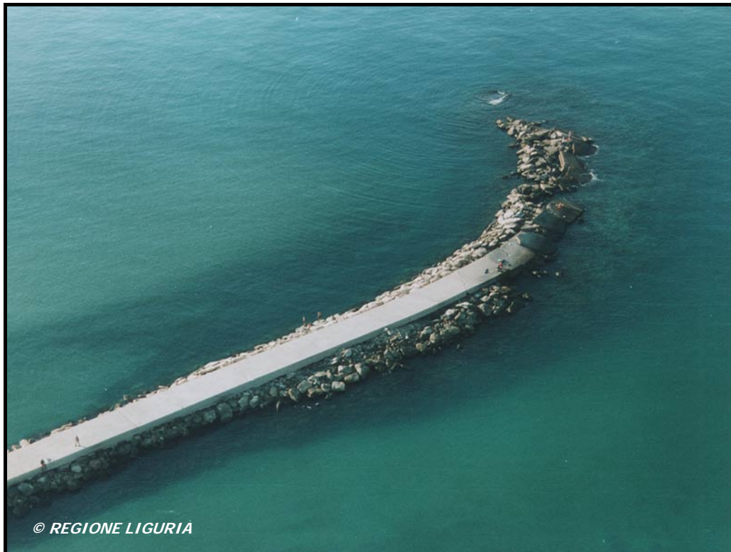
Figure 2 – Exemple d’un ouvrage littoral
