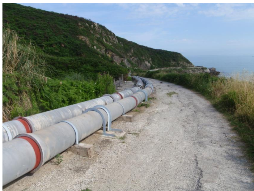
Figure 4. Le pipeline de chlorure de calcium à l'ouest de la plage d'Usgo.
