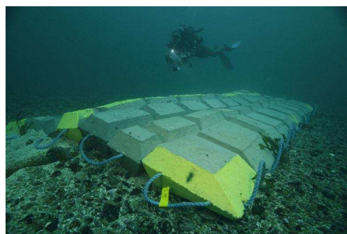
Plongée de comptage sur le câble de Paimpol-Bréhat, protégé par des matelas de béton colonisés par de grands crustacés. © Ifremer - O. Dugornay
