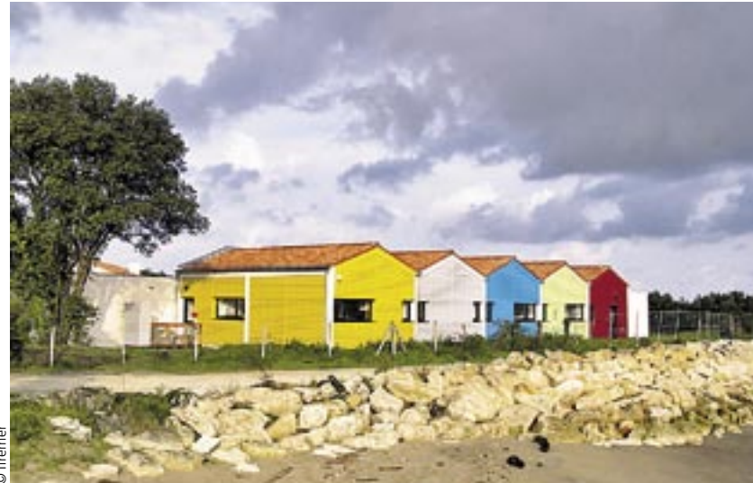
Les nouvelles infrastructures de la station Ifremer de La Tremblade.
